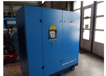
Compresor de tornillo 55 kw. WORTHINGTON CREYSSENSAC ROLLAIR RLR 75A
